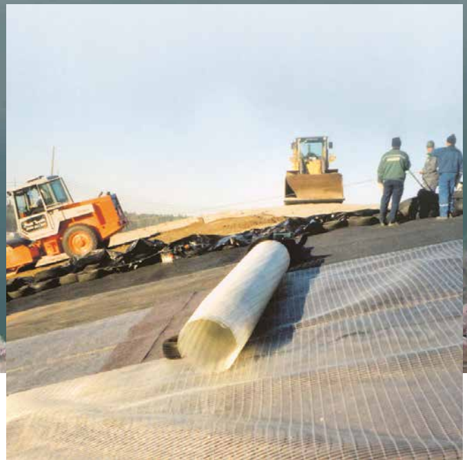
Kaatopaikan pintarakenteiden vaativa suunnittelu- ja rakennustyö
