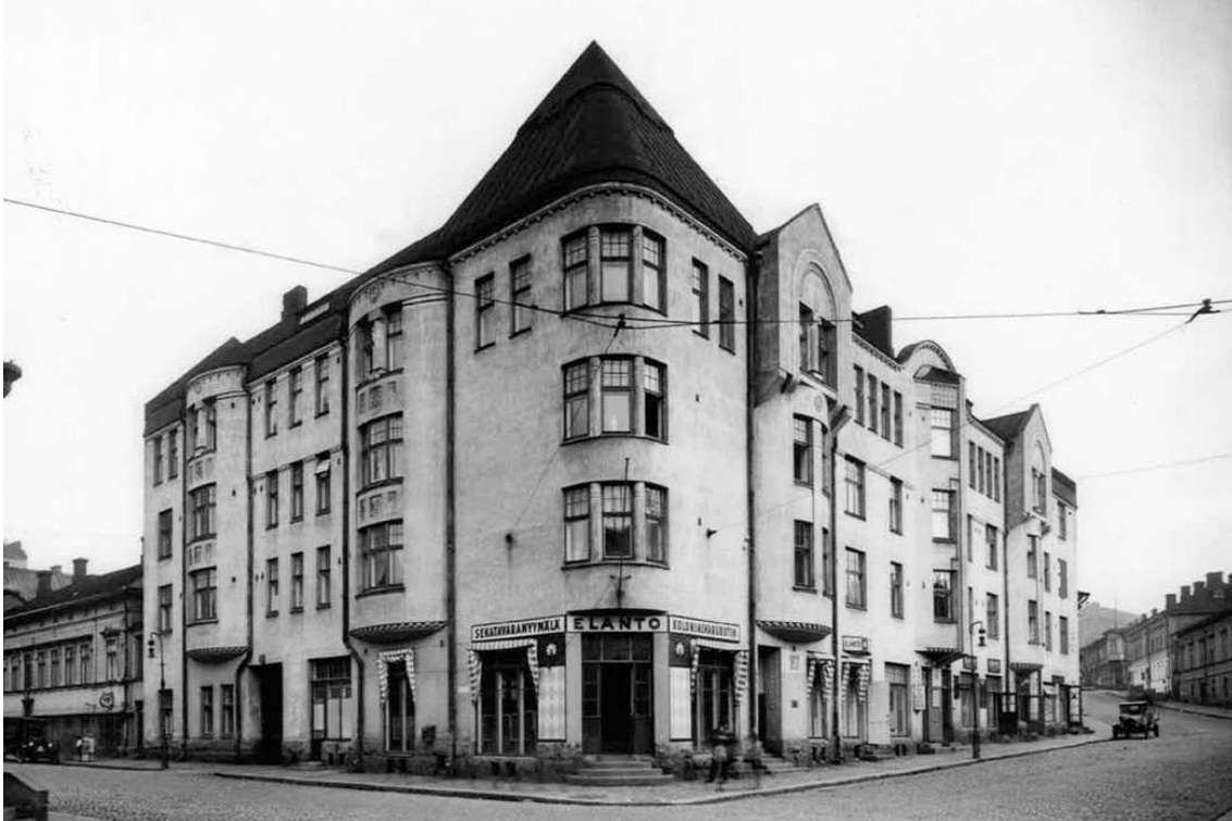
Pursimiehenkatu 27, julkisivusaneeraus vanhaa kunnioittaen. FCG: projektinjohto ja työmaavalvonta. Historiallinen rakennus on rakennettu jo vuonna 1907.
