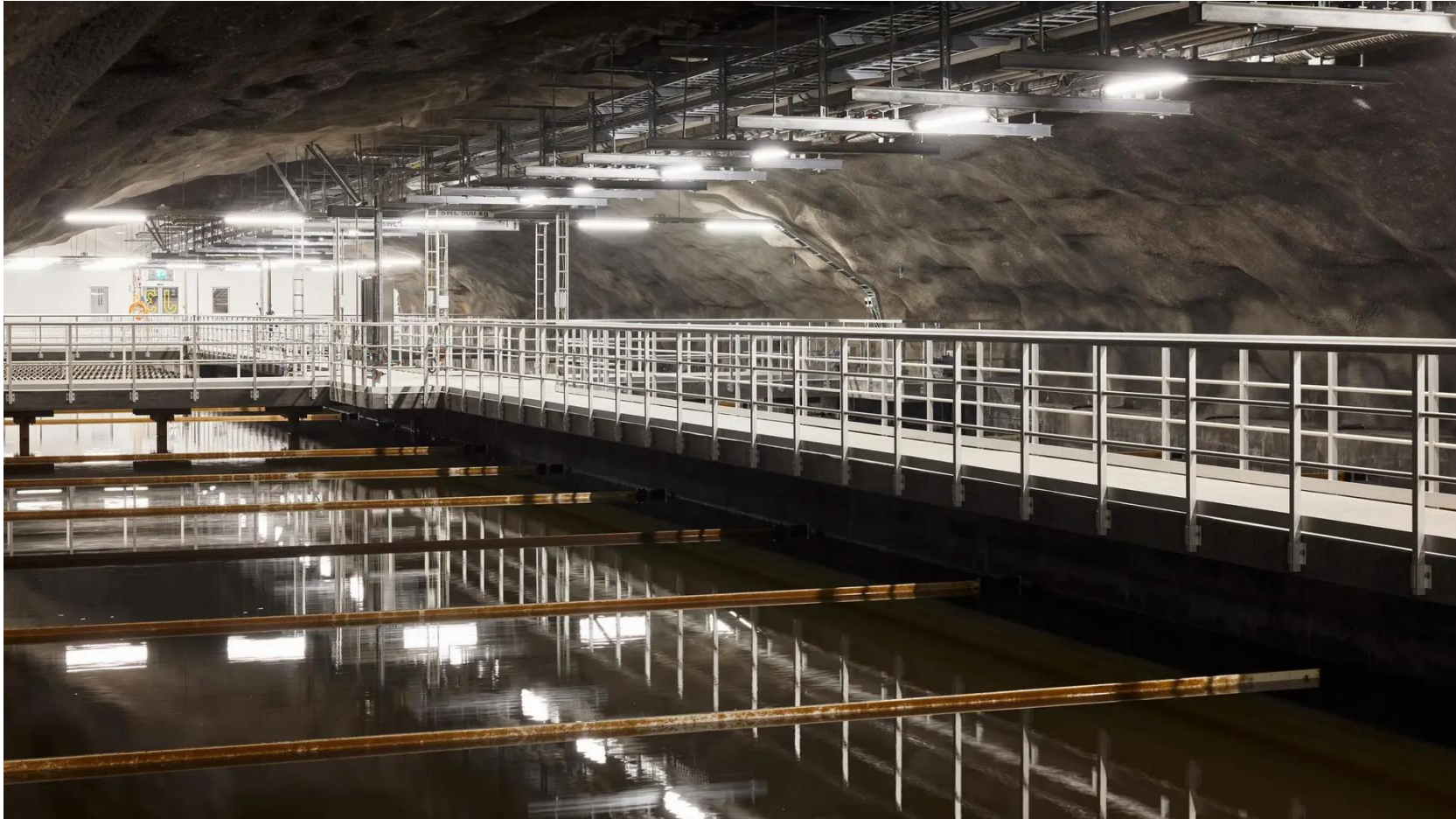
HSY, Blominmäen jätevedenpuhdistamo
